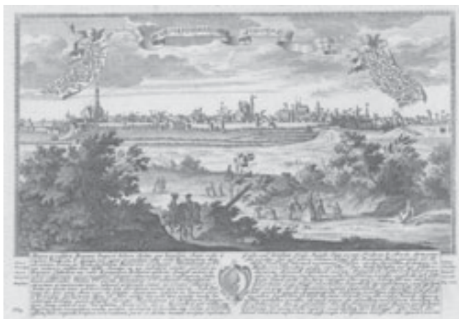
Nr. 13 - Augsburg - Gesamtansicht von J. Chr. Leopold
