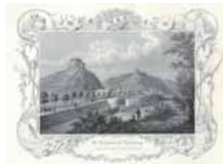
Nr. 434 - Riedenburg-Schleuse - Stahlstich von Marx
