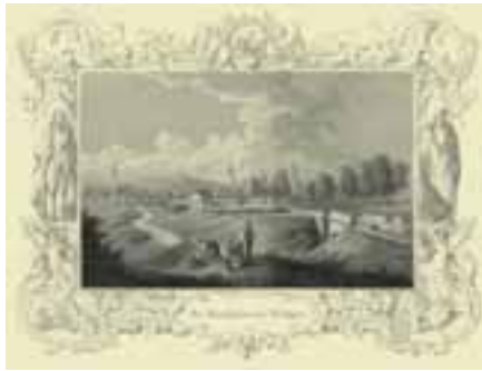
Nr. 266 - Erlangen-Kanalhafen - Stahlstich von Marx
