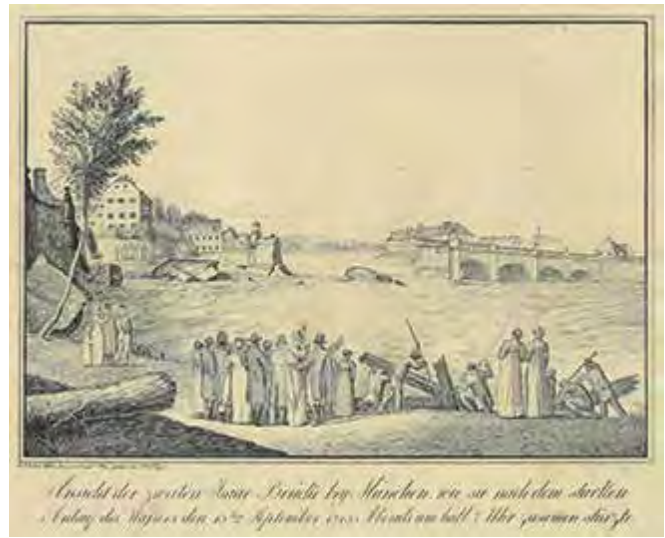
Nr. 282 - München - Einsturz der Isarbrücke 1813 - Steingravur von C. Wennig
