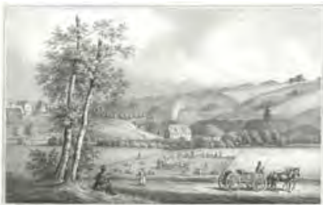
Die Hüttenwerke bei Mansfeld
